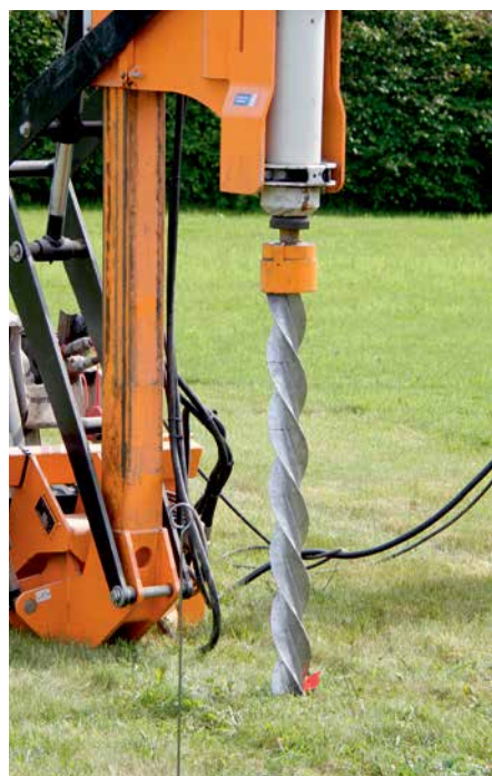
Einrammen der Gewindepfähle Enfoncez les pieux
