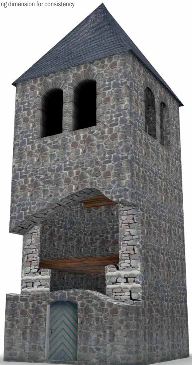
Verbindung abgelöster Mauerwerkschalen Connection of separated wythes
